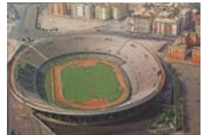
Lo stadio Collana di Napoli è stato restituito dal Comune alla Regione: stanno iniziando i lavori per l'adeguamento dell'impianto alle esigenze dell'Universiade.
